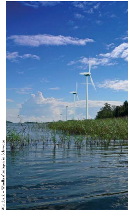
Windpark – Windkraftanlagen in Schweden
